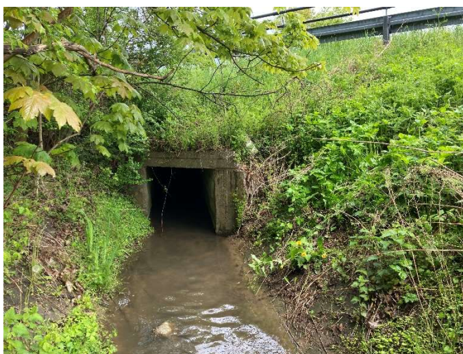
Figur 6: Longsrøftens udløb fra Vordingborgvej i st. 1.008 m.
